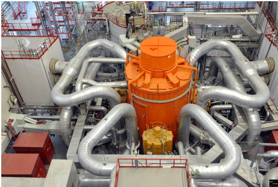
Центральный зал. Реактор
