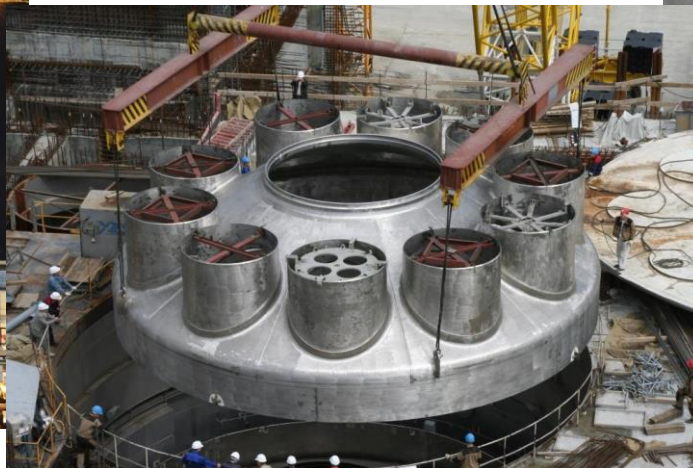
Монтаж крыши реактора
