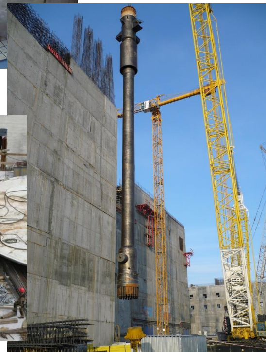
Монтаж модуля ПГ
