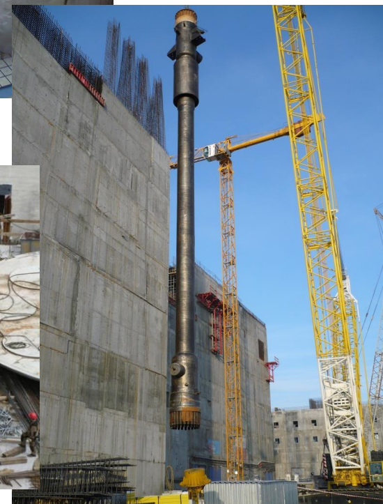
Монтаж модуля ПГ
