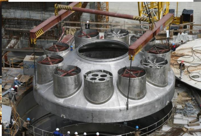
Монтаж крыши реактора
