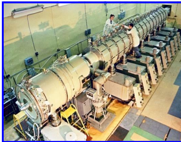
Линейный индукционный ускоритель ЛИУ-10 для комплексных испытаний ВТ с реактором ГИР-2
